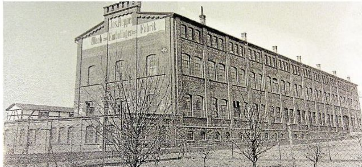
1898 baute Joseph Heppel dieses Fabrikgebäude mit 4700 Quadratmeter Nutzfläche an der Stiftstraße nahe der Diezer Straße. Das Gartengelände ist heute ein Parkplatz.
