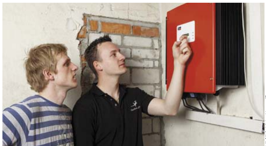
Jeder Arbeitsschritt bei der Montage wurde den Jugendlichen von Geckologic-Techniker Christian Ott (rechts) genau erklärt
